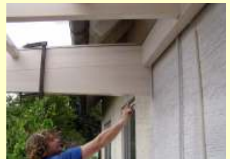
3. ... und verbunden, bevor die Aufteilungen unter die Randsparren geschraubt werden können.
