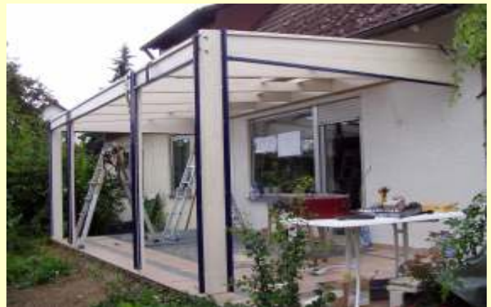
5. Auf die Rahmen des Traggerüsts werden Anschlagprofile aus Aluminium aufgebracht und abgedichtet.
